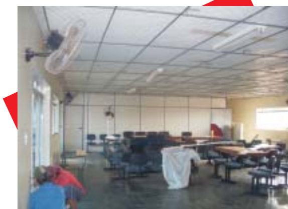
Reforma salão andar superior Início da construção do auditório
