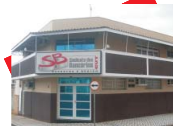
Reparos e nova pintura na sede do Sindicato - Concluída
